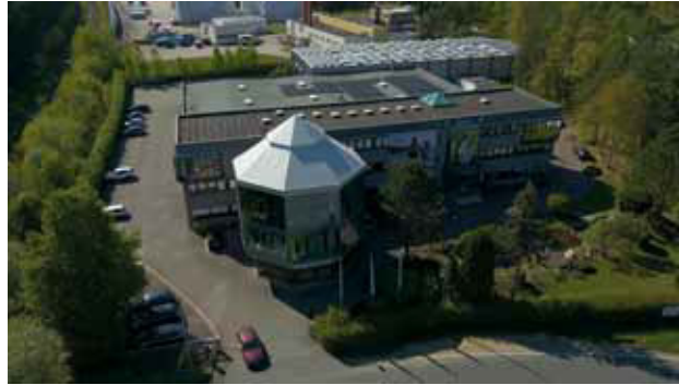
Oktogonale Form des Neubaus © Onmind GmbH/Gruschwitz GmbH
